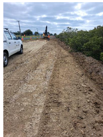
Maukoro Canal stopbank
